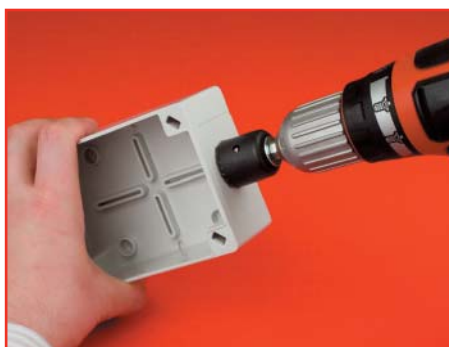
Сверлим отверстия необходимого диаметра
